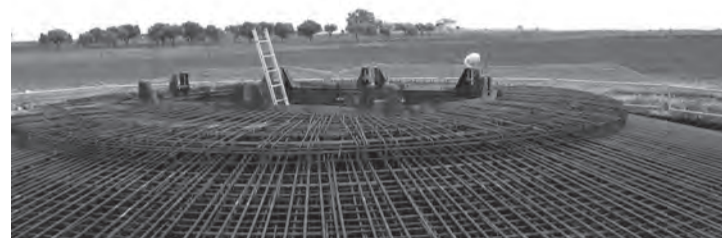
Immagine eloquente delle fondazioni in cemento armato che occorrono all'installazione di un aerogeneratore. Lo scempio irreversibile che si fa al territorio è devastante.
