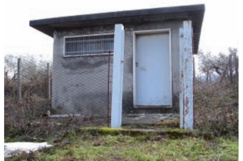
Serbatoio dell'acquedotto comunale in via del Rio Vivo (foto: A. Longo)
