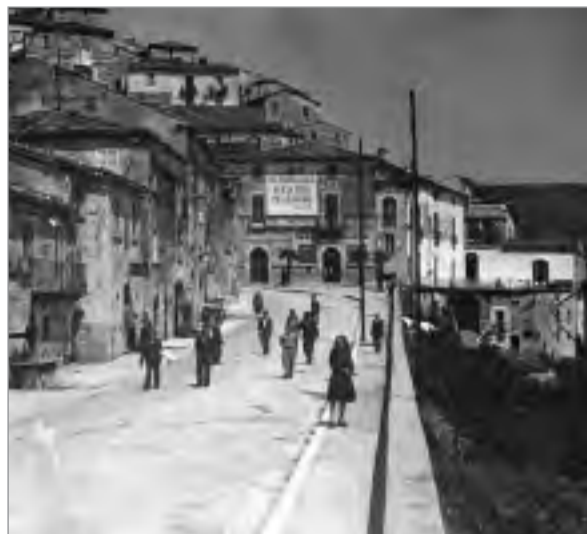
Foto d'epoca prima del “taglio strutturale” del palazzo
