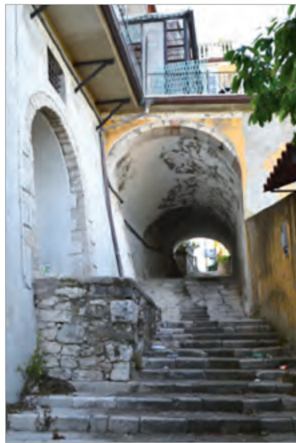
Antico sottopassaggio di accesso al borgo sottostante il palazzo
