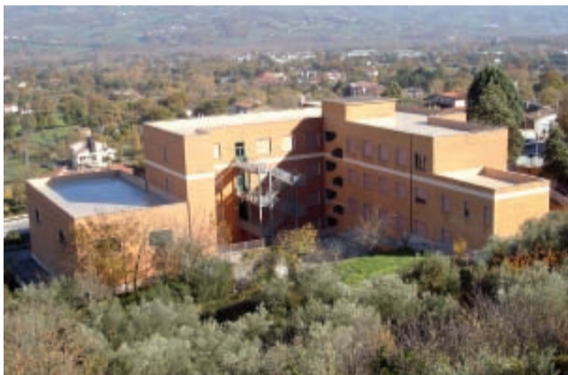
L'edificio delle scuole medie
