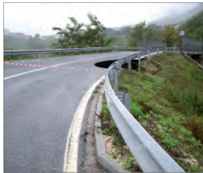
Lo svincolo di Sassinoro sulla Statale 87
